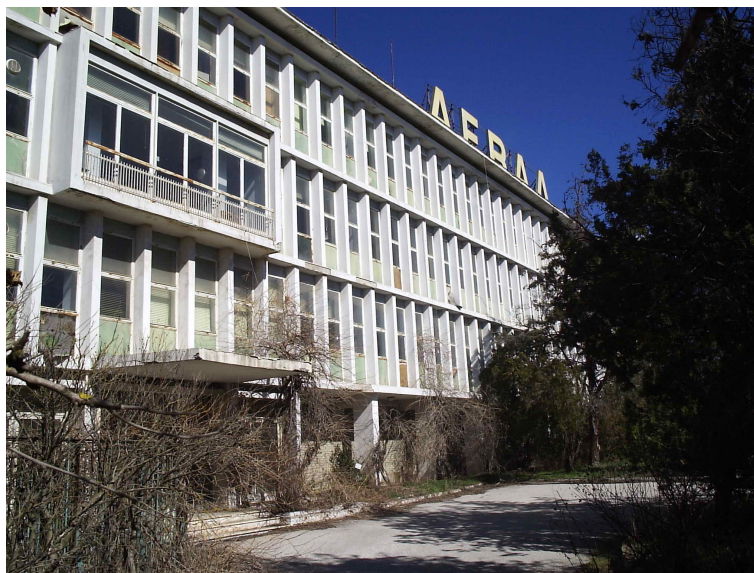
Άποψη του κτιρίου Διοικήσεως, το οποίο θα ανακαινιστεί και βρίσκεται εντός της Ζώνης Διοίκησης και Εκπαίδευσης.
