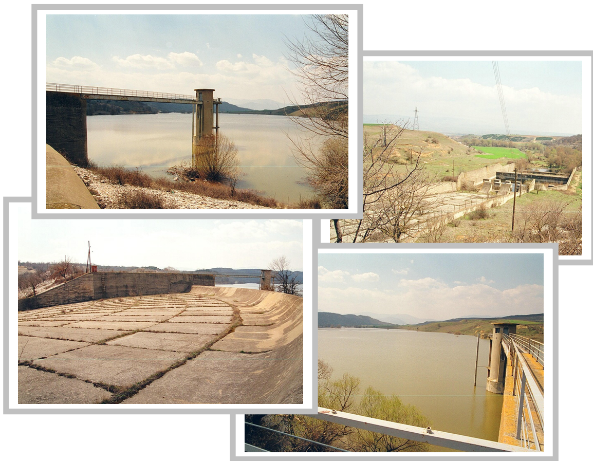
ΑΠΟΨΕΙΣ ΤΩΝ ΕΓΚΑΤΑΣΤΑΣΕΩΝ ΤΟΥ ΦΡΑΓΜΑΤΟΣ ΠΕΡΔΙΚΚΑ ΔΗΜΟΥ ΠΤΟΛΕΜΑΪΔΑΣ
