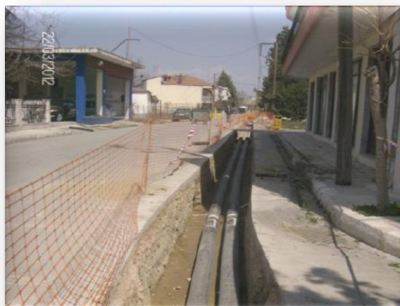
Εικόνα 4. Πρωτεύον Δίκτυο Διανομής. Κατασκευή Δ' Φάσης.
