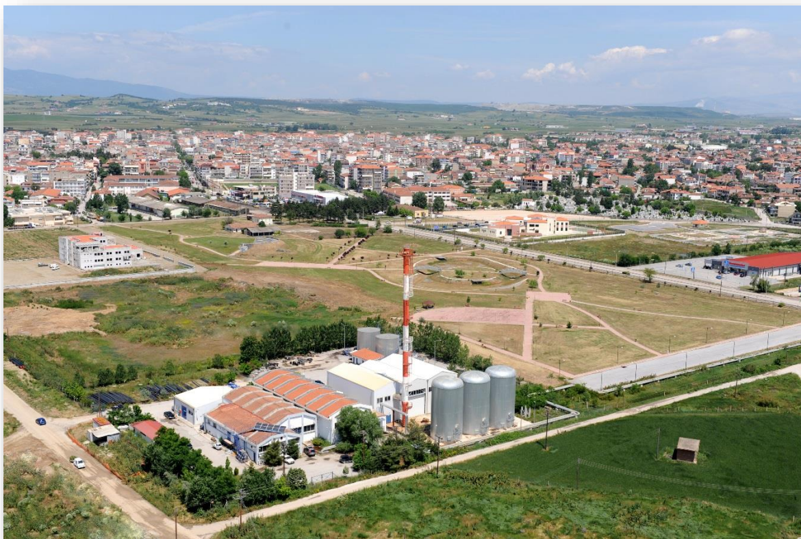
Εικόνα 1. Κεντρικό Αντλιοστάσιο Δ.Ε.ΤΗ.Π. στην νότια είσοδο της Πτολεμαΐδας (φωτό 2009)
