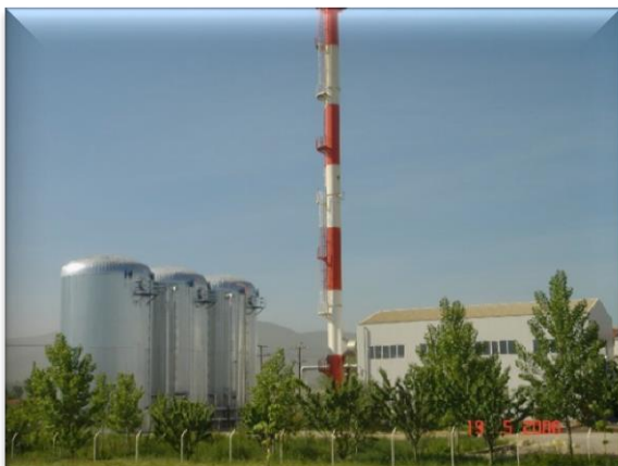
Εικόνα 5. Δεξαμενές αποθήκευσης θερμικής ενέργειας - Κεντρικό αντλιοστάσιο ΔΕΗΠ.
