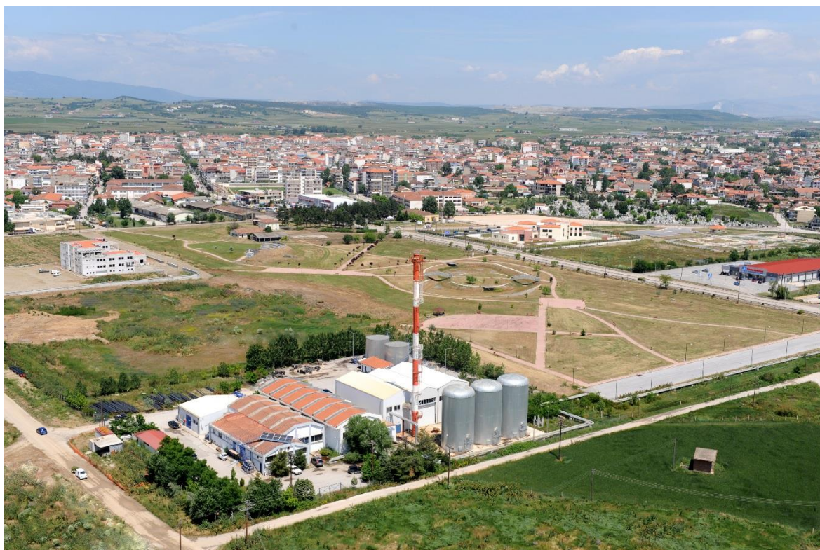
Εικόνα 1. Κεντρικό Αντλιοστάσιο ΔΕΤΗΠ στην νότια είσοδο της Πτολεμαΐδας
